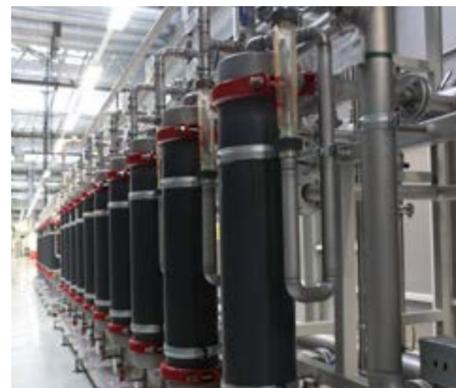
通过电泳超滤反渗透系统，减少工艺废水排放。
